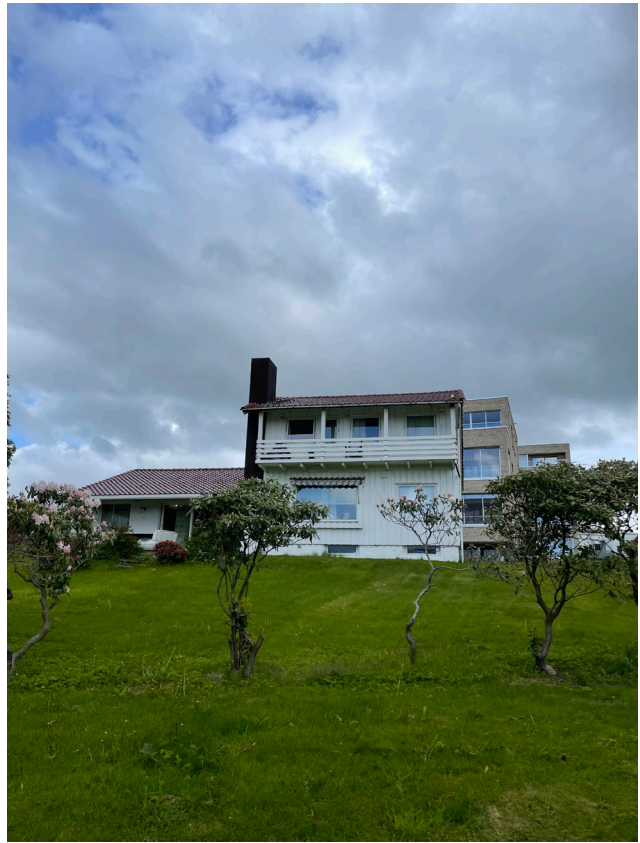
Fig. 3 Carlsen- eiendommen. Sett fra sør
