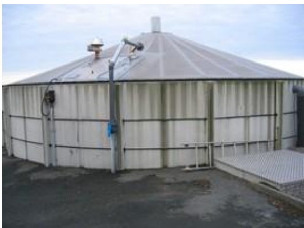
Biogassreaktor, foto: Johannes Ingvaldstad, Norges Bondelag
