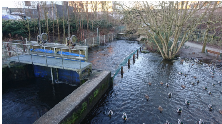
Figur 4: Utløpet av Frøylandsvatnet. Luka er til venstre i bildet. Her er vannstanden så høy at vannet renner over en mur til høyre for luka. Foto: Ingjerd Haddeland/Statens vegvesen.
