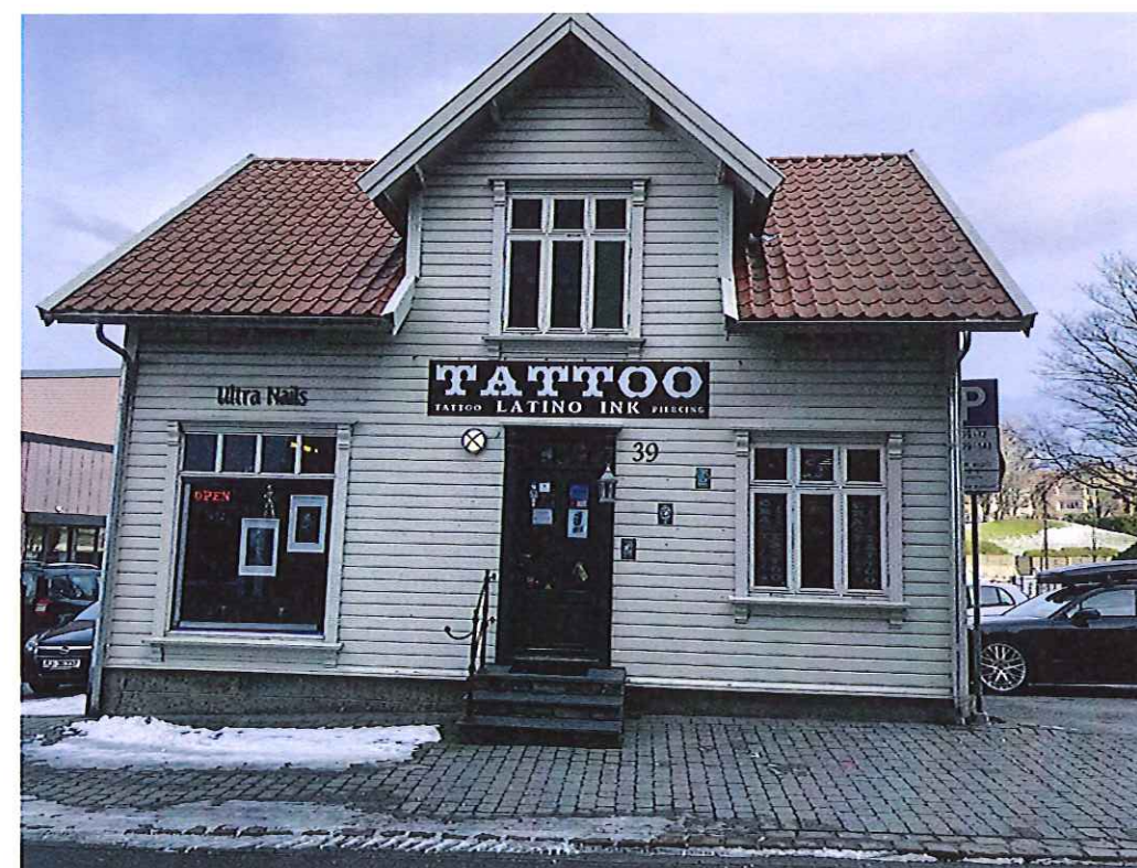
Steinslandshuset med fasade sør mot Storgata 2019
