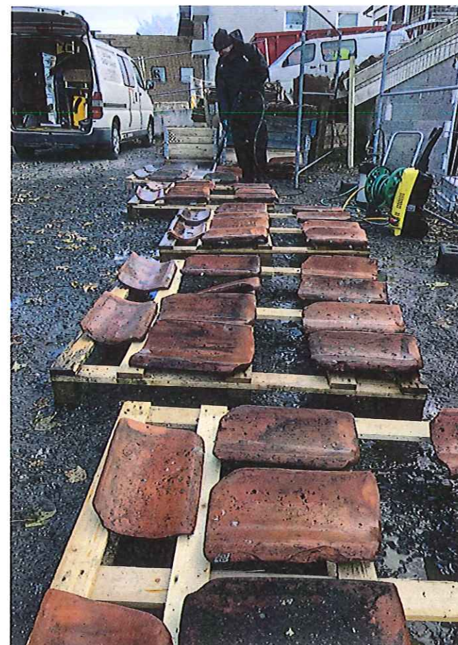
Den originale taksteinen av tegl blir brukt videre etter rengjøring og utsortering.
