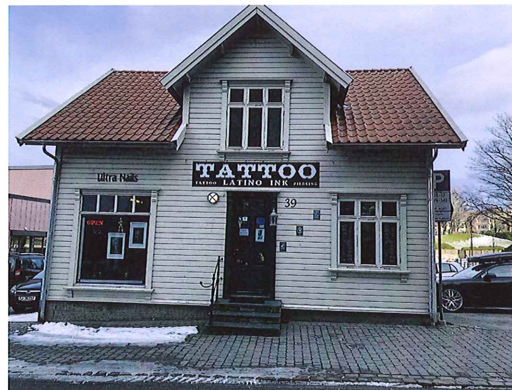
Steinslandshuset med fasade sør mot Storgata 2019
