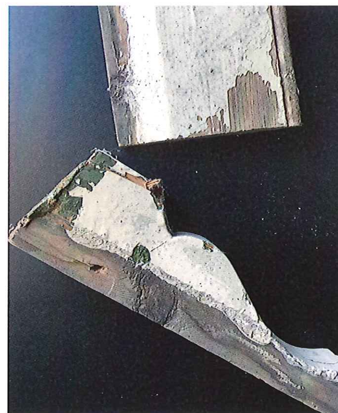
Kledningsbord og vindusknektar forteller om fargebruk i fasaden gjennom tidene. Noe må fornyes, men deler av gamle bygningsmaterialer kan brukes på ny.
