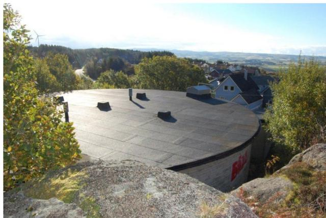
Lye, vannspeil kote 205, volum 1 100 m<sup>3</sup>. Dekker øvre og nedre del av Lye.
