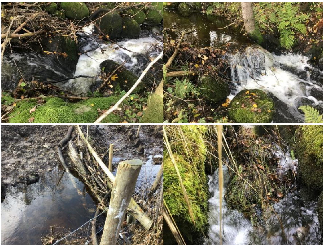
Figur 136. ØV: Vandringshinder 1 ØH: Vandringshinder 2 NV: Vandringshinder 3. Her er det 3 gjerder etter hverandre i bekkeløpet. NH: Vandringshinder 4, ansamlet materiale på gjerde som danner 50 cm fall.
