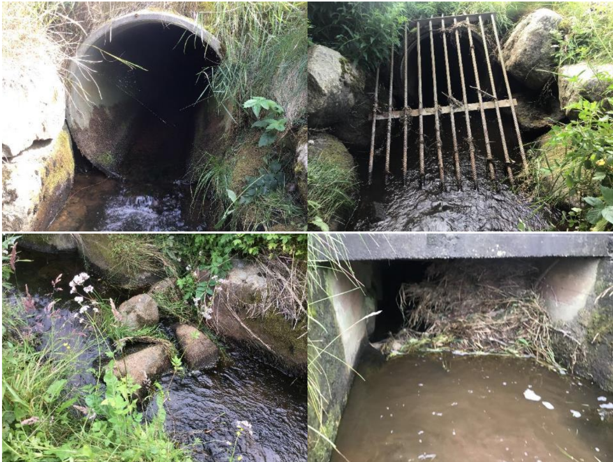
Figur 63. ØV: Vandringshinder 1, rør med lav vannsøyle ved lav vannføring. ØH: Vandringshinder 2, rist med 10,5 cm spalteåpninger. Denne er tilnærmet vandringsstengsel for større gytetfisk. NV: Vandringshinder 3, utraste blokker som danner hinder ved liten vannføring. NH: Vandringshinder 4. Øvre del av bred kulvert hvor ansamling av materiale periodevis kan utgjøre vandringshinder.
