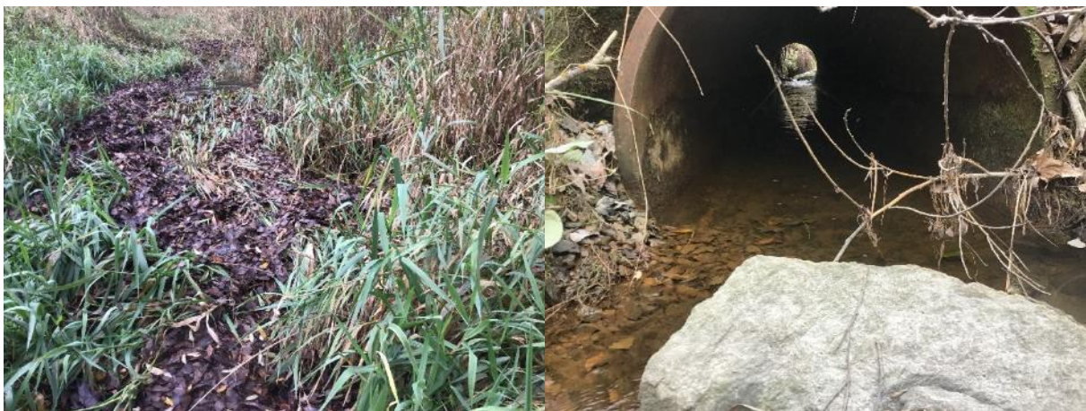
Figur 143. Venstre: Vandringshinder 6, tett vegetasjon. Høyre: Over 200 meter av bekken er lagt i rør, men ingen av disse bekkelukkingene utgjør vandringshindre.
