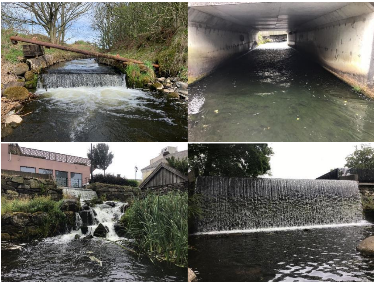
Figur 48. ØV: Vandringshinder 1, i sone 5. ØH: Vandringshinder 3, i sone 19. Bred kulvertbunn med lav vannsøyle og sterk strøm. NV: Vandringsstengsel 5, sone 19. NH: Vandringsstengsel 4 (Møllefossen), sone 19.
