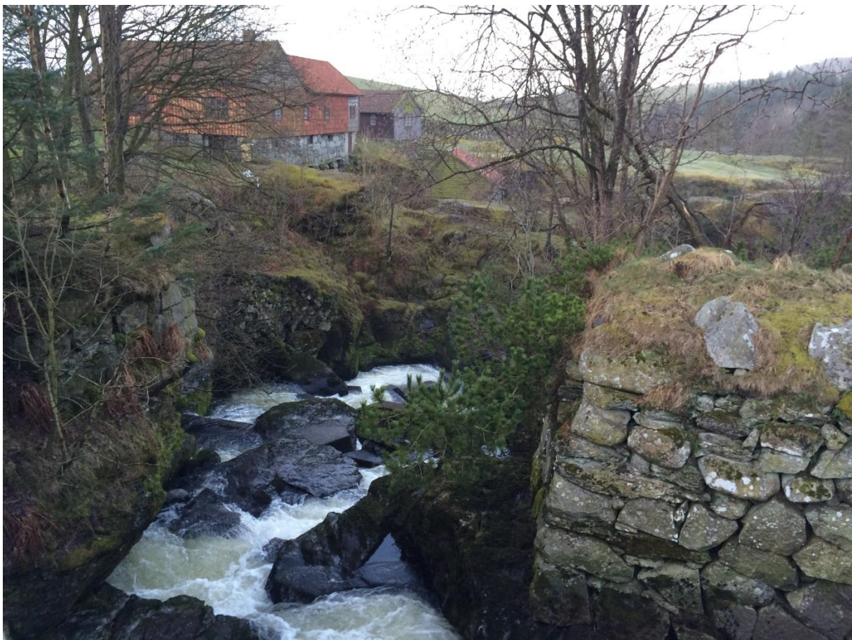
Figur 9 Laksetrapp ved Fotlandsfossen og rester av gl. brukar. (foto. Erik Larsen)
