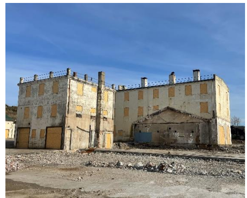
To av dei fem bygga som ikkje har fått rivingsløyve og står att i området
