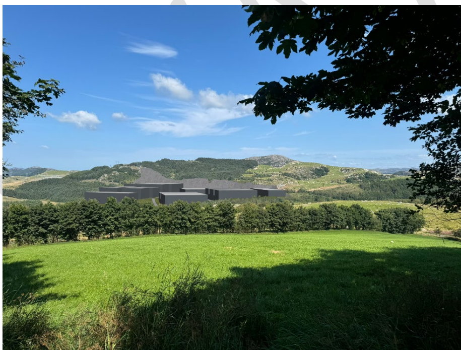
Standpunkt nr. 11: Alternativ 1-1 (Etter utbygging) sett mot NK3
