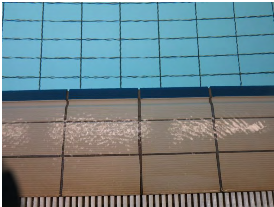
Bilde 11 Nærbilde av rennen som er av type Finlandsrenne
