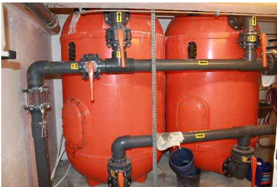
Bilde 38 Sandfilterne er modne for utskifting.
