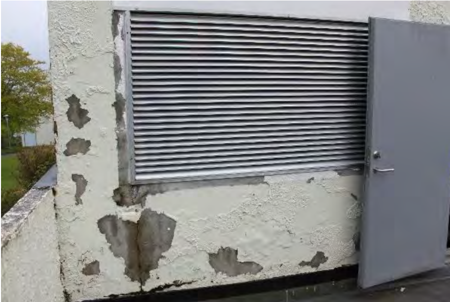
Bilde 46 Det kan være aktuelt å skifte inntaksristen til en mer værsikker type, (widerist)
