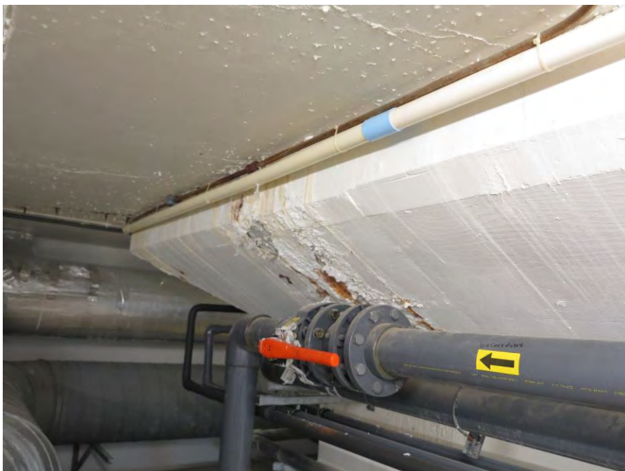
Bilde 30 Lekkasje i støpteskjøt mellom basseng og omliggende gulv.
