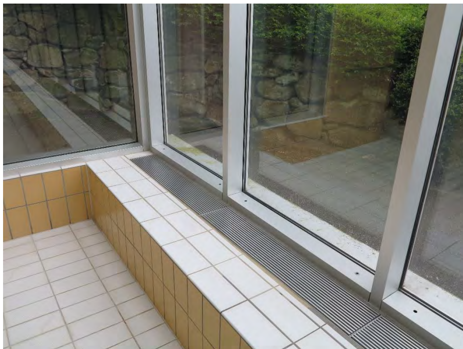
Bilde 5 Ytre hjørne i glassfasaden, med ventilasjonsrister for bestrykning av vinduene med overtemperert luft.
