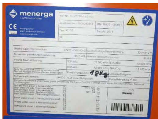
Bilde 45 Aggregatet er fra 2014 og i god stand. Det har imidlertid ikke bassengvannskondensator, dette skyldes at anlegget ligger relativt langt fra teknisk rom under bassenget.
