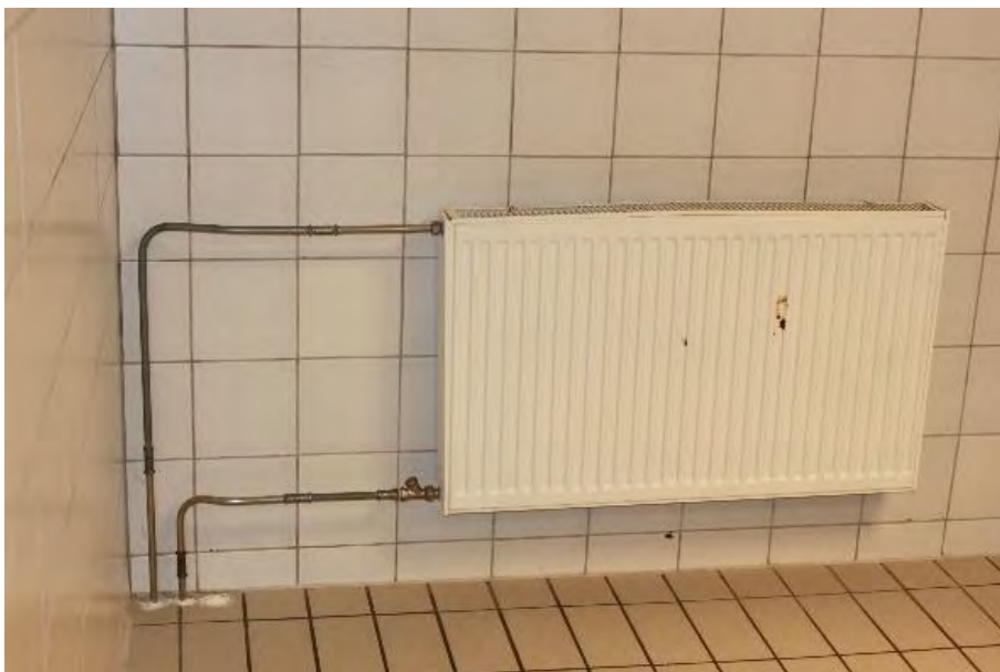
Bilde 28 Varmeanlegget rehabiliteres i garderobedelen
