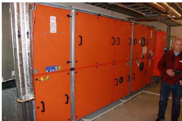
Bilde 45 Aggregatet er fra 2014 og i god stand. Det har imidlertid ikke bassengvannskondensator, dette skyldes at anlegget ligger relativt langt fra teknisk rom under bassenget.
