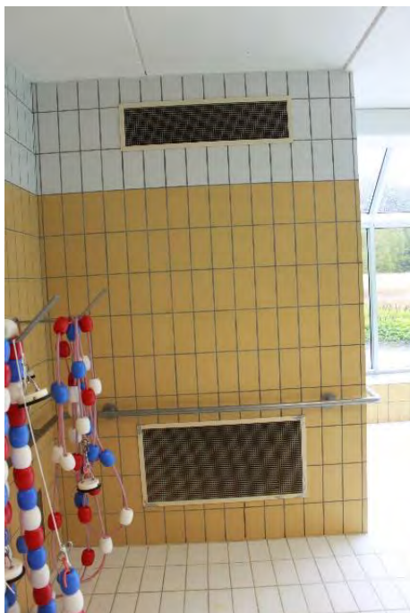
Bilde 21 Ventilasjonsanlegget kan stort sett beholdes uendret for svømmehallen, men kanaler og avtrekksventiler må rengjøres.
