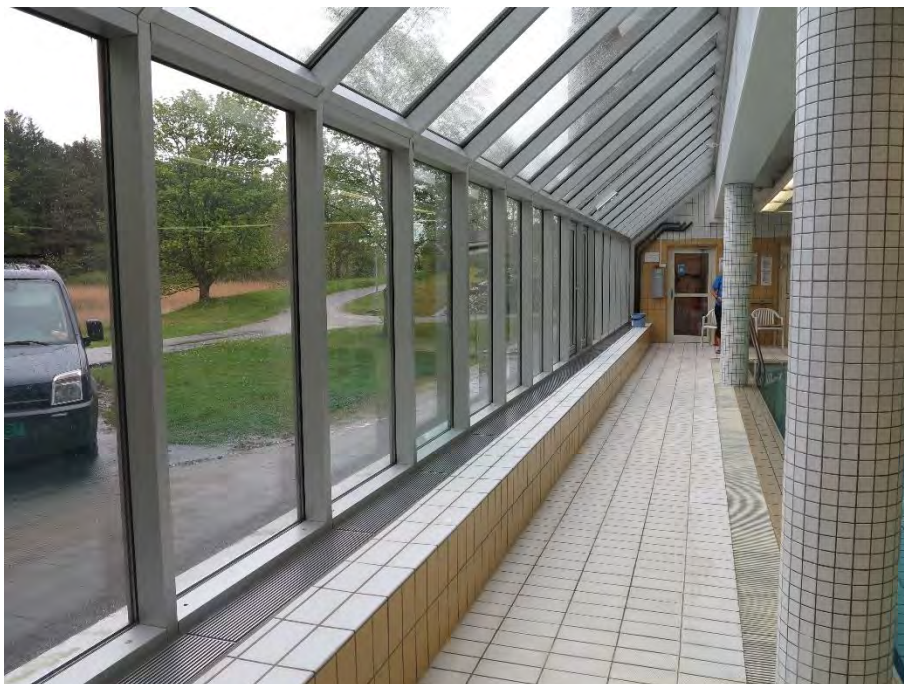
Bilde 3 Glassfasaden sett fra innsiden. Vinduene bestrykes med ventilasjonsluft via ristene som ligger mot bunnprofilen.
