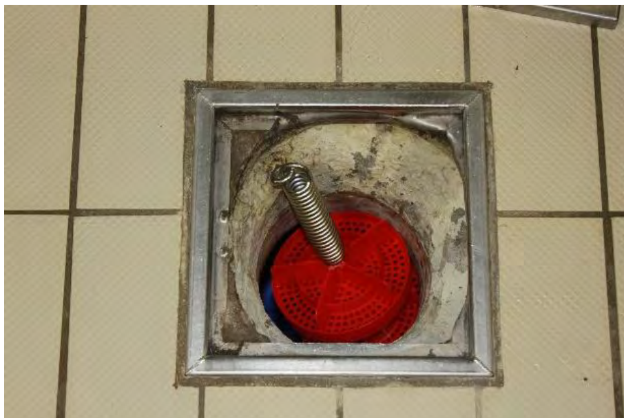
Bilde 15 Hull for baneskillerne er for trange i forhold til de nye baneskillerne og må oppgraderes med nye hull og luker.
