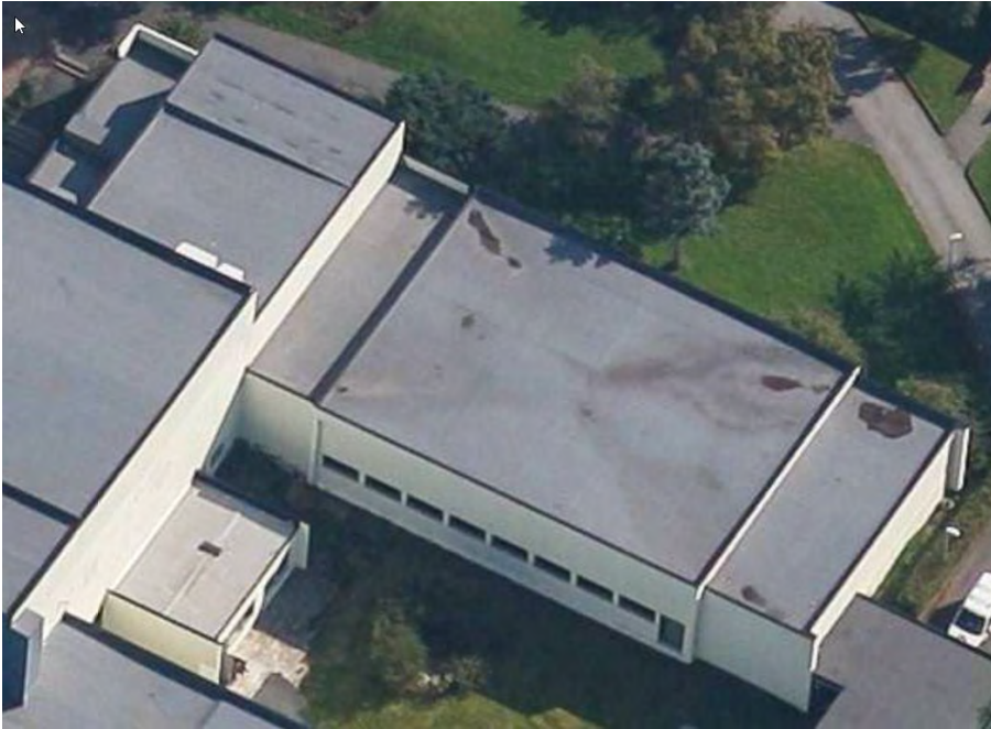
Bilde 1 Skråfoto fra www.1881.no , sett fra vest. Det er i nyere tid bygget til en gjennomgang til Brynehallen som ses nederst til høyre på bilde. Bildet indikerer også at tak generelt er oppgradert med ny takfolie.
