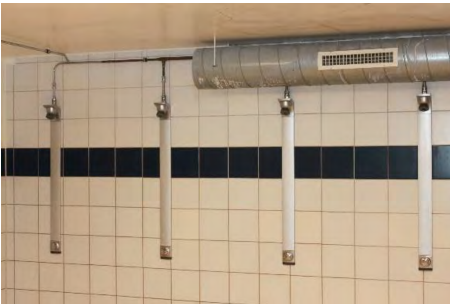
Nye dusjer og kanaler/tilluftsventiler når garderobene rehabiliteres
