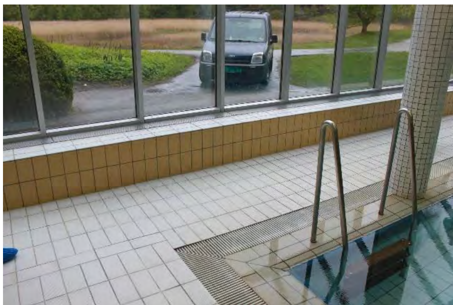
Bilde 8 Hjørne på bassenget med omliggende gulv. Som vi kan se er det ikke egen spyleregne rundt bassenget, noe som gjør at vaskevann lett havner ned i renne og blander seg med bassengvannet.
