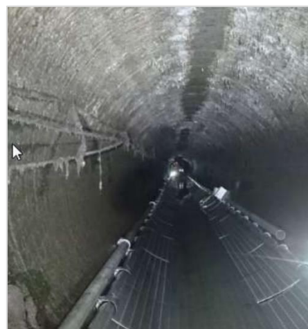
Figur 42 Triangulum varme- og kjøleanlegg i Stavanger med varmepumpeaggregater (2 x 250 kW) og varmevekslere montert i bunnen av avløpstunnelen (foto – Fredrik Skaug Fadnes).
