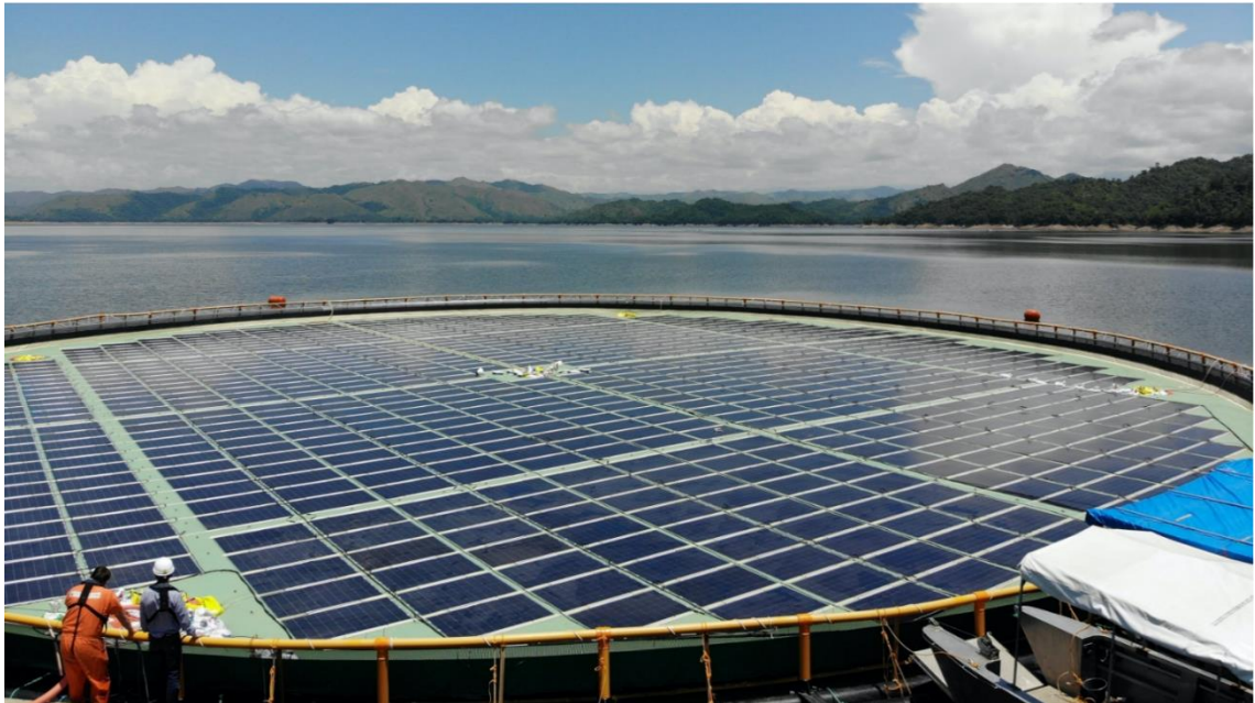
Figur 30: Illustrasjonsbilde av flytende solkraft med installert effekt på 220kWp utført av norske Ocean Sun [40]
