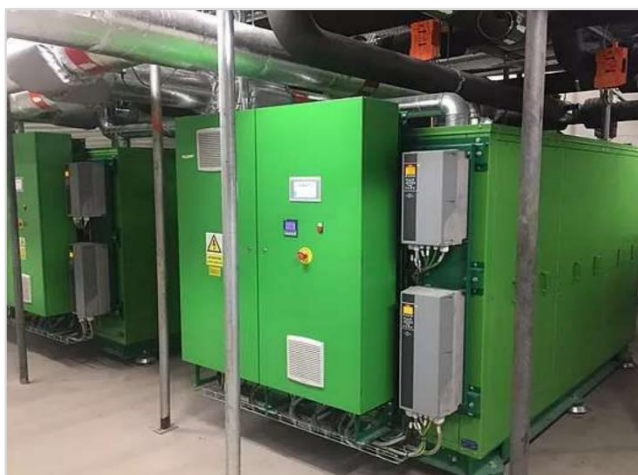
Figur 42 Triangulum varme- og kjøleanlegg i Stavanger med varmepumpeaggregater (2 x 250 kW) og varmevekslere montert i bunnen av avløpstunnelen (foto – Fredrik Skaug Fadnes).
