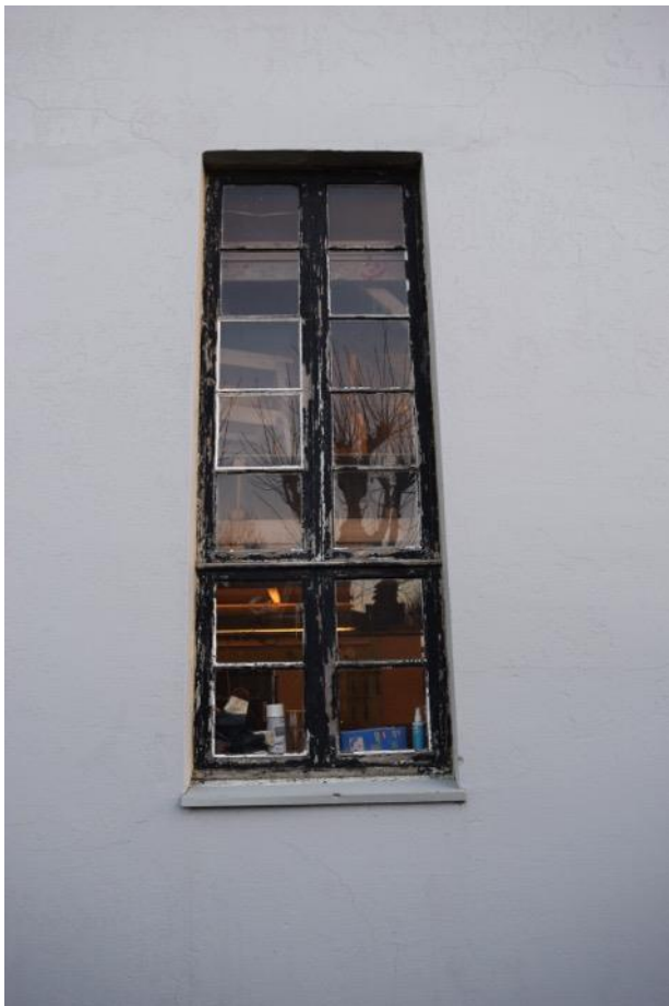
Originale vinduer i fasade
