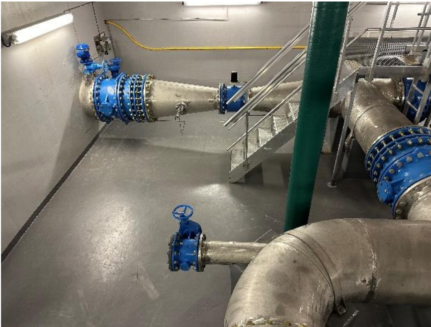
Figur 2-7: Ventilkammer 1126 sørvest for prosjektområdet med ledig uttak for påkobling.
