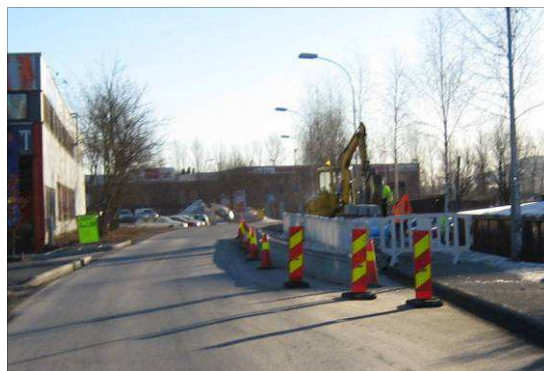
Riktig utført sikring og varsling.
