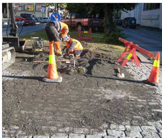
Etterfuging av brosteinarealer.
