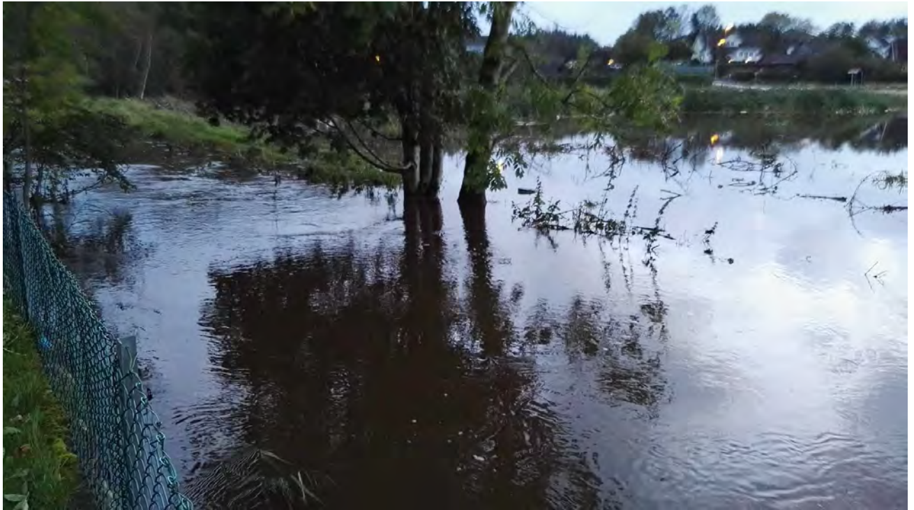
Bilde 11: Kalbergbekken – bilde av flom fra høsten 2017. Kalbergbekken går også over bredden ved 28/881 på årlig basis. Treffer Frøylandsbekken ved pumpehuset.
