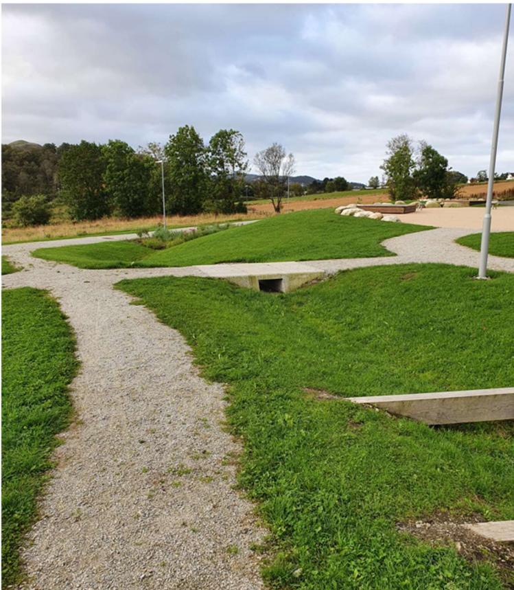
Figur 14 Gresskledd forsenkning, foto Asplan Viak
