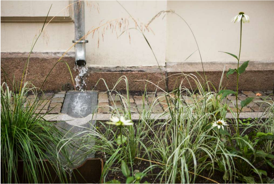
Figur 13 Taknedløp til regnbed, foto Åse Holte
