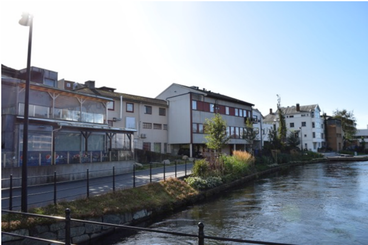
Bildet viser Storgata 17 sett fra gangbro over Bryneåna.
