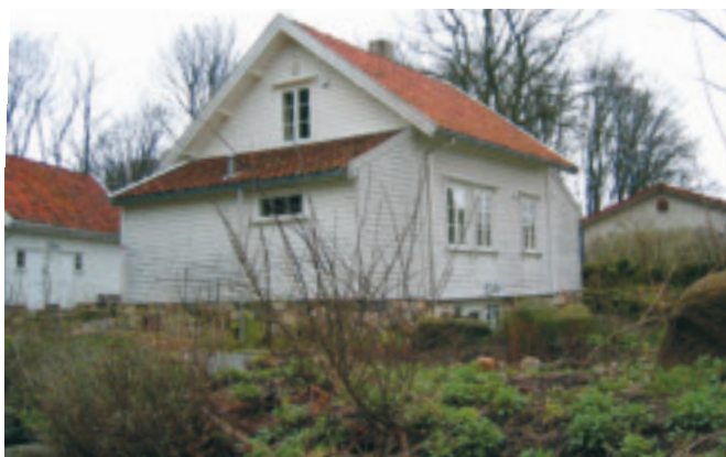
68. Arkjå – gnr. 9/69 – sandneskasse med påbygde skutar på Hognestad. Dette huset vart bygd på Undheim (Kålnes gnr. 46/57) i 1912, men vart flytta ”på rot” og svært pietetsfullt restaurert på Hognestad i 2006. Uthus i same stil som huset. KPL
