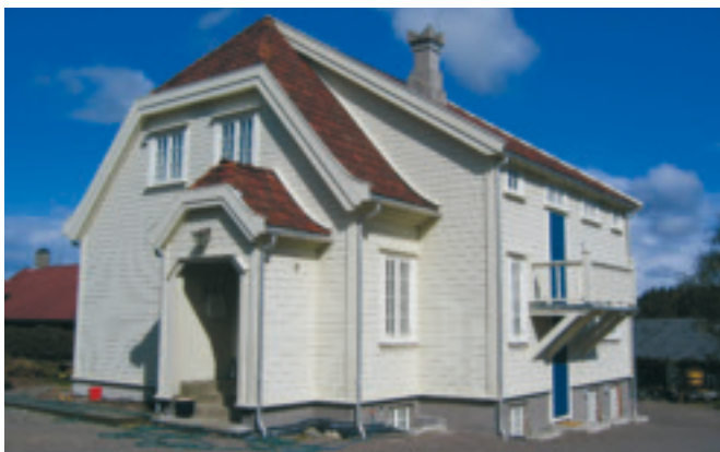
45. Heimly – Lendehuset, gnr. 2/23. Bygd 1917 av stasjons- og postmeister Jens Lende. Staseleg hus som nå er utvendig restaurert av nåv. eigar. KPL
