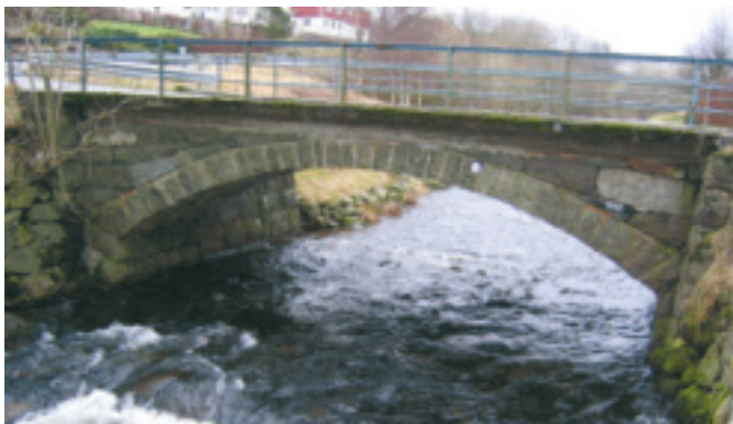
50. Undheim bru – gnr. 46 – bygd 1901. Steinbogebru i Undheim sentrum. Delvis skjult av dekket frå ny bru, som vart bygd over i 1959. Boge og brukar i kilt stein er heilt intakte. KPL
