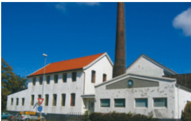
i. Holmen – bedriftsbygning og kontorlokale, gnr. 1/53 – i Bryne sentrum. Bygd som Jæderens Uldvarefabrik i 1896, modernisert i 1948. I Serigstadfamilien si eige som jordbruksreiskapsfabrikk og støyperi frå 1938 til det vart selt i 2004. Eldste industribygning i stasjonsbyen. Føreslege verna av Time kulturminnenemnd i 2004. SOB.
