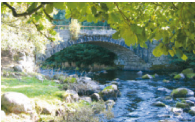
49. Fosse bru – gnr. 13 og 59 – mellom Oma og Fosse vart bygd i 1898. Bua har den største steinkvelven i enkeltspenn på Jæren KPL
