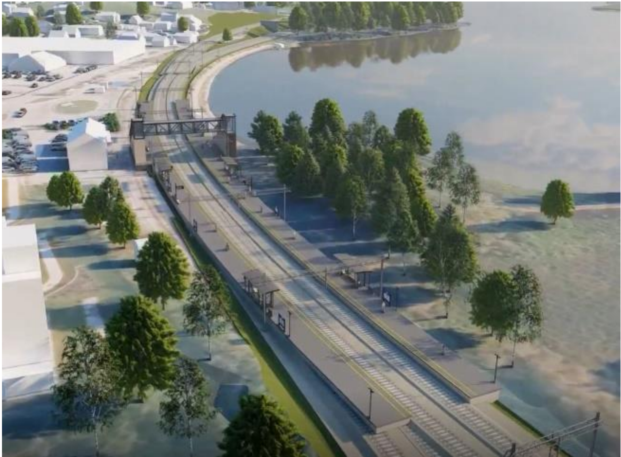
Figur 32. På Klepp stasjon erstattes dagens midtplattform med to sideplattformer, Dagens kryssing av sporet i plan vil bli stengt. Det erstattes med en overgang bak stasjonsbygget. Overgangen vil også ha gangforbindelse med turvegen langs Frøylandsvatnet.
