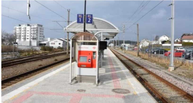
Figur 9. Nærbø stasjon. Foto: Bane NOR
