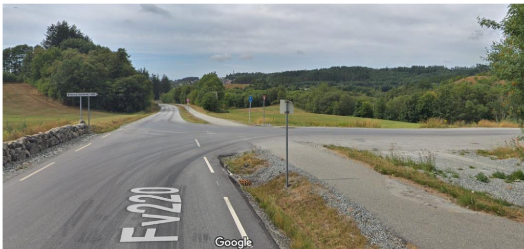
Figur 1-3. Utsnitt av avkjørselen til masseuttaket fra Åslandsvegen sett mot vest. Kilde: Google maps
