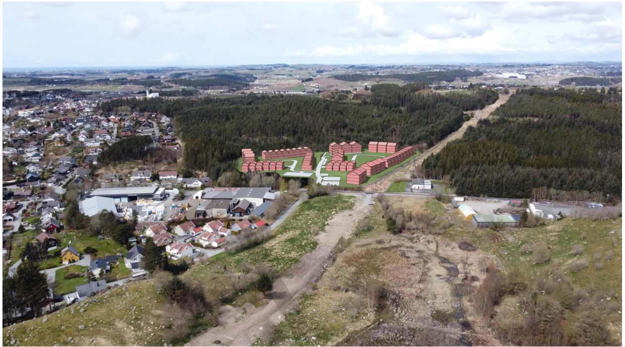
Figur 5: Oversiktsbilde som viser forslag til ny bebyggelse i BK1 mot Kalbergskogen i nord, sett fra sør. Utarbeidet av AFRY ark studio
