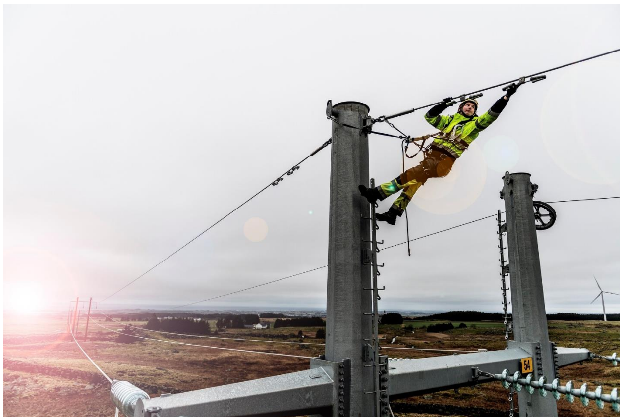
Fra bygging av ny 132 kV kraftlinje mellom Kartavoll og Opstad i Hå kommune (Foto: Fredrik Ringe, januar 2020)
