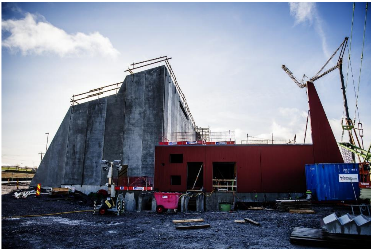
Bygging av Nye Opstad transformatorstasjon i Hå kommune (Foto: Fredrik Ringe, mars 2020)
