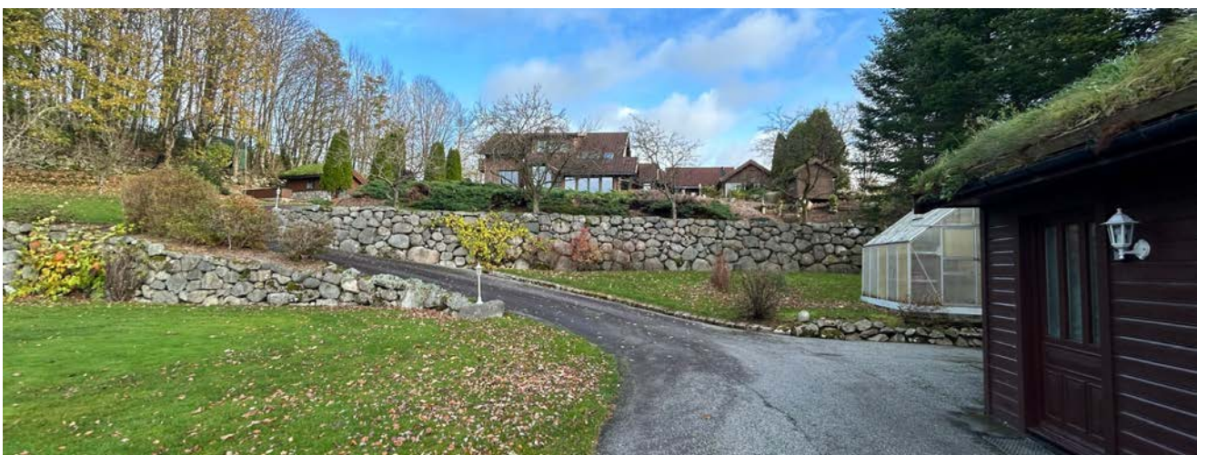
Pumpehus til høyre og planerte nivåer sett fra vest mot øst. Eksisterende bolig i bakgrunnen.
