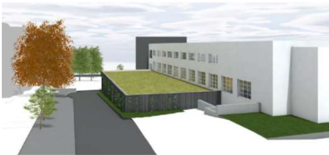
Garasjen sett i fugleperspektiv fra sør
