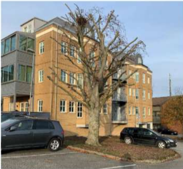
Bøka øst for Hulda Garborgsveg 9 bevares.
