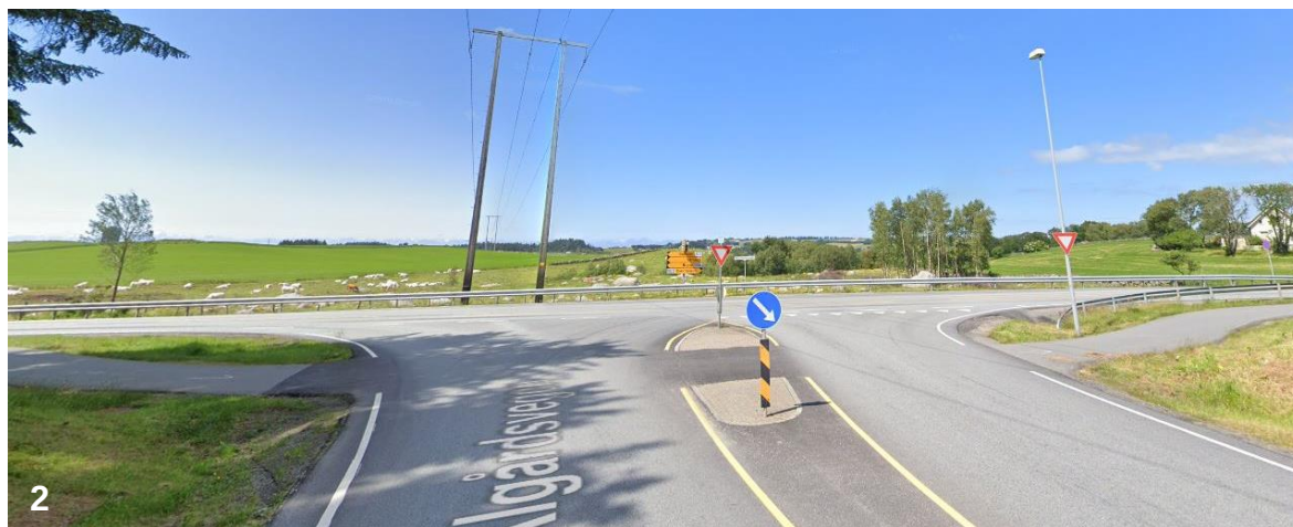
Figur 3-3 Tilrettelagt kryssing over Fv. Algårdsvegen.
