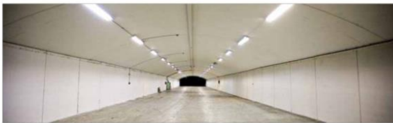
RENNESØY: Fjellanlegget på Hodne rommer gigantiske haller. I løpet av et år kan de gjøres klare til innflytting for Cern. (Foto: Lars Idar Waage)
