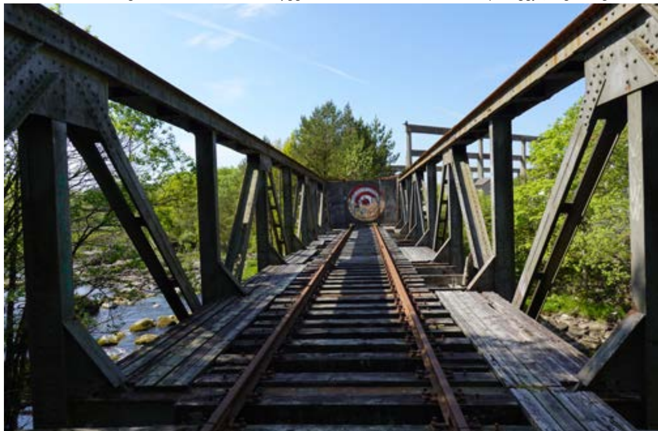
Fagverksbruen over Figgjoelva er med å unnerstreke Ålgårdsbanen som samferdselshistorisk kulturminne
