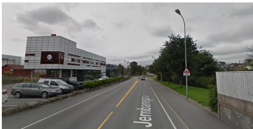
Figur 5-4. Jernbanegata, med planområdet på høyre side i bildet og industri/kontor på venstre side.
