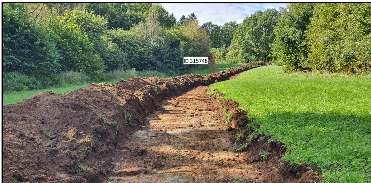
Figur 88 Viser sjakt 14.43 som går over den smale flaten med ID 315748 markert midt på bildet. Sett mot SV. Foto: 643.
