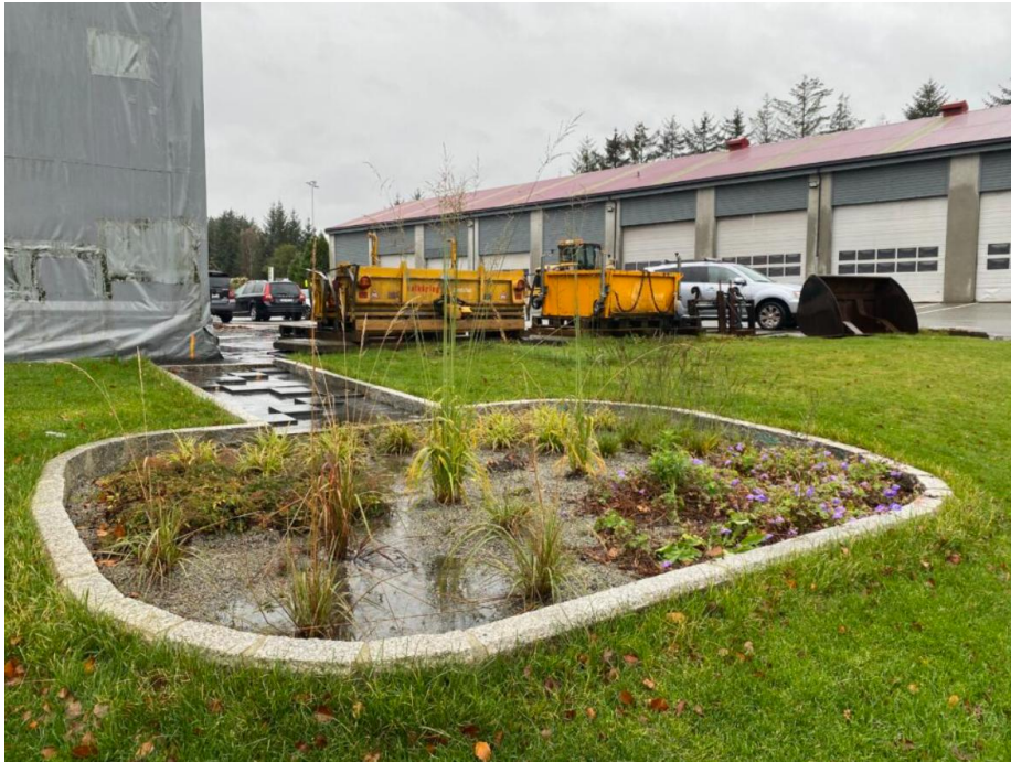
Figur 42: Regnbed som renser avrenning fra vei og parkering i Sandnes. Foto: Inger Anita Merkesdal, Vannfakta.no.
