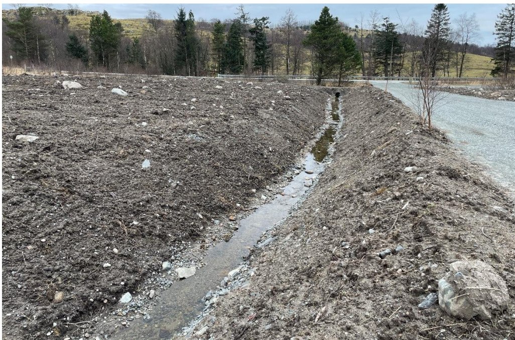
Figur 22: Nedre del av bekken som renner ut av NK3 før kryssing under Åslandsvegen og utløp i Frøylandsbekken.
