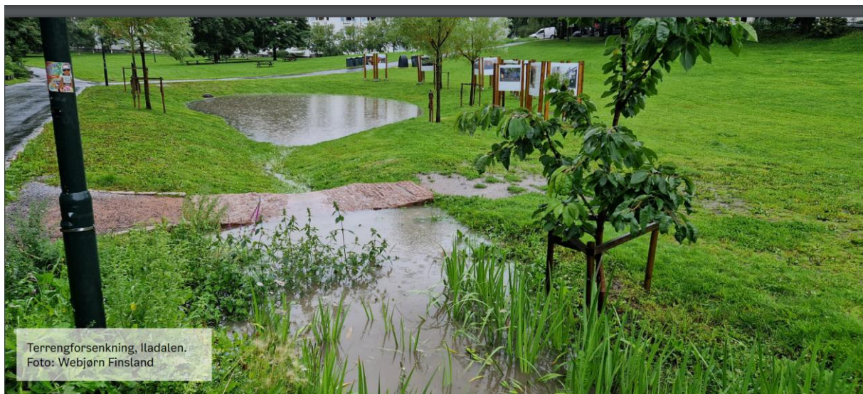
Figur 43: Eksempel på åpent fordrøyningsområde i terrengeforsenkninger, hentet fra Oslo kommune sin veileder for overvannshåndtering.
