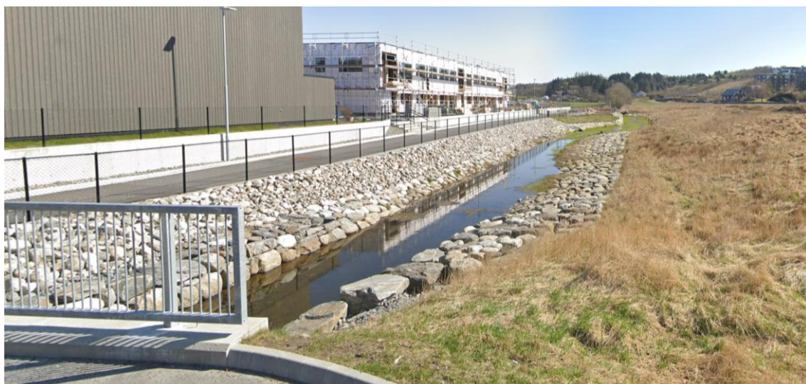
Figur 16: Østre del av Orstadbekken der den krysser Tjeldvegen langs nytt boligområde sett i retning mot KN6. Foto: Google Street View.
