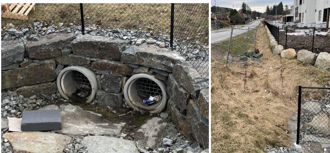
Figur 31: Nylig etablert flomløp for Kalbergbekken (A6) med gitter inni røret som raskt gjentettes. Disse må fjernes og eventuelt erstattes med en utvendig rist med horisontal del og mulighet for fjerning i en flomsituasjon.
