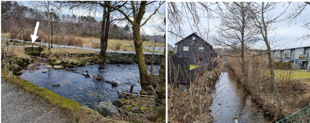
Figur 5: Frøylandsbekken ved splitten oppstrøms Stemmen (venstre) og gjennom sentrumsområdet (høyre). Nålestengsel som regulerer vannføringen mot Stemmen er vist med pil.
