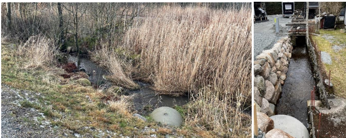
Figur 6: Bilde av Kalbergbekken nedstrøms trafostasjonen langs Kalbergvegen og gjennom bebyggelsen (venstre).
