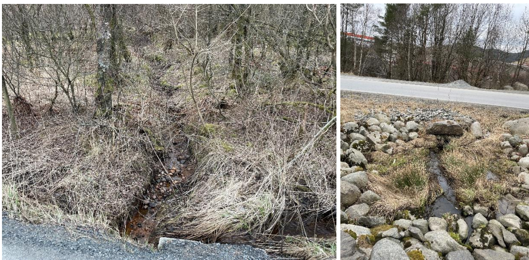
Figur 36: Bilde av bekken fra KN6 (venstre) og fra rensedammene (høyre) ved kryssing under Kalbergveien.
