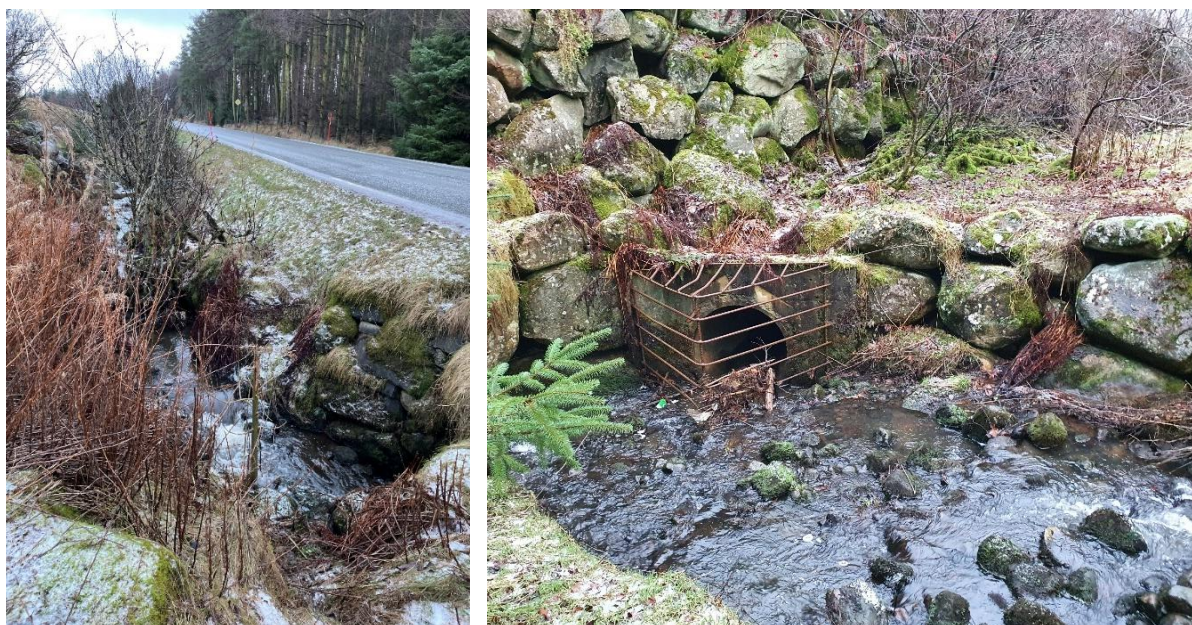
Figur 10: Bilde av bekken og de to mest kritiske punktene ved Fjermestadvegen før den går lukket nesten fram til Frøylandsvatnet.
