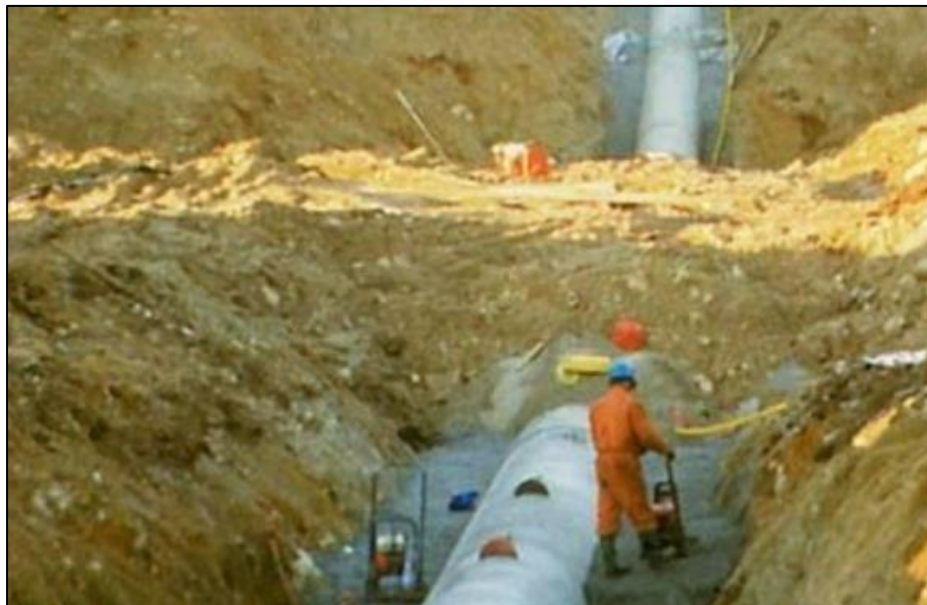
Figur 6-1 I anleggstiden vil grøften være åpen, og nødvendig areal avsatt til mellomlagring av masser, utstyr med videre, vil bli omlag 20 m til hver side av ledningen.
