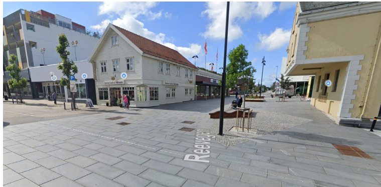
Figur 1-3: I 2019 var Reevegen ombygd til gatetun og envegsregulert sørover mellom Storgata og Meierigata (Google Maps Streetview, 2019). Nå er gata stengt i begge retninger på denne strekningen.
