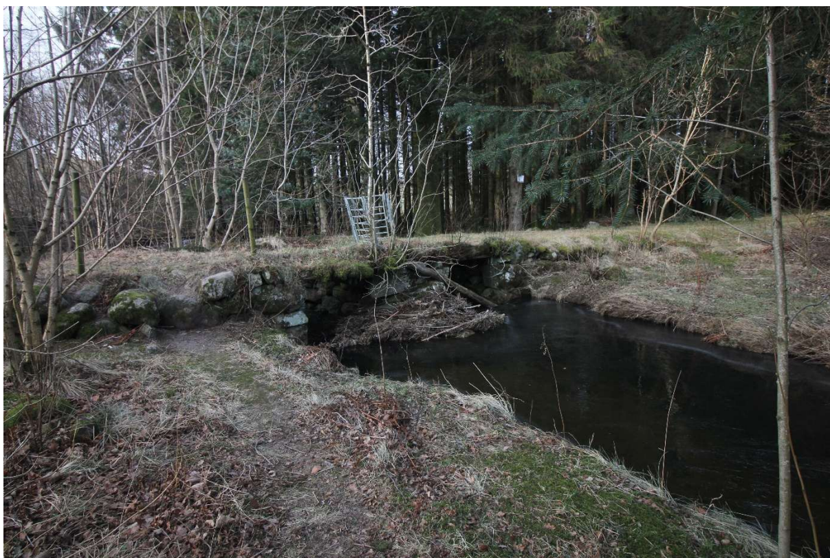
Figur 6-31. S 3, bru over Frøylandsåna ved Gamle Kalbergvegen.
