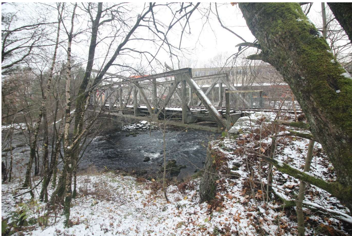
Figur 6-2. Fagverksbru, bygd til Ålgårdsbanen i 1924.
