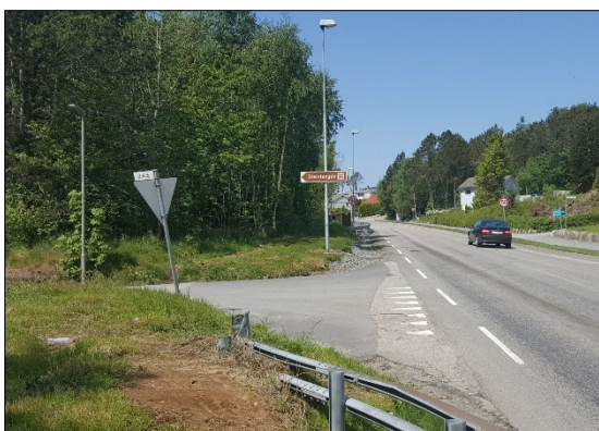
Figur 40: Avkjørsel til BMX-banen.
