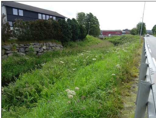
Figur 31: Kantsone langs østsiden av Frøyland bru.
