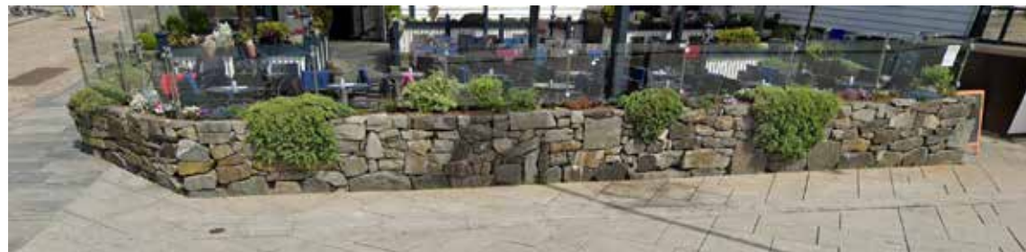
Steingjerde i urbant miljø. Foto: google street view fra Stavanger sentrum.
