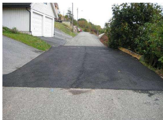
Riktig etter pålegg om endring
