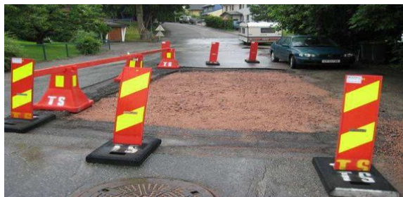
Riktig klargjort for asfalt inkl. fresing av fortanning.
