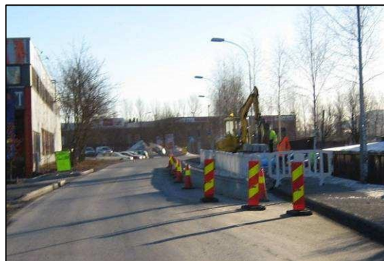
Riktig utført sikring og varsling
