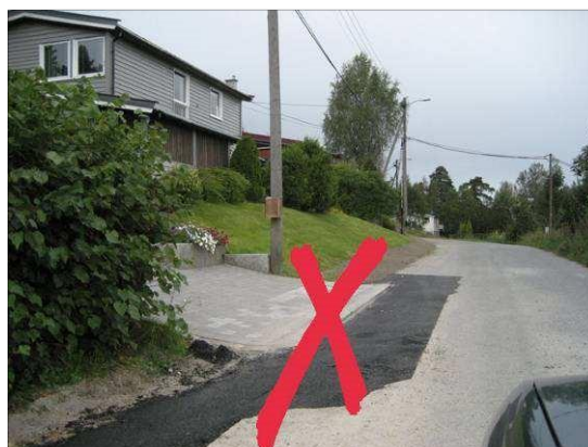
Uønsket endring av grøftetrasé
