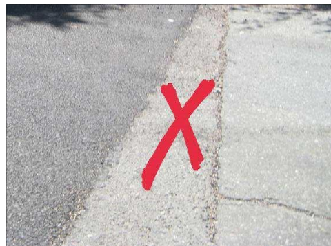
Minst 5 meter til neste skjøt.
